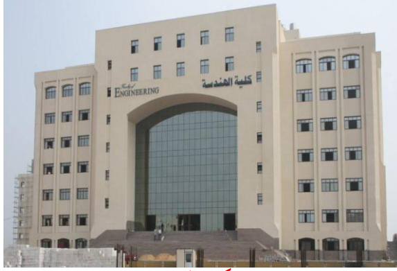
مبنى كلية الهندسة
